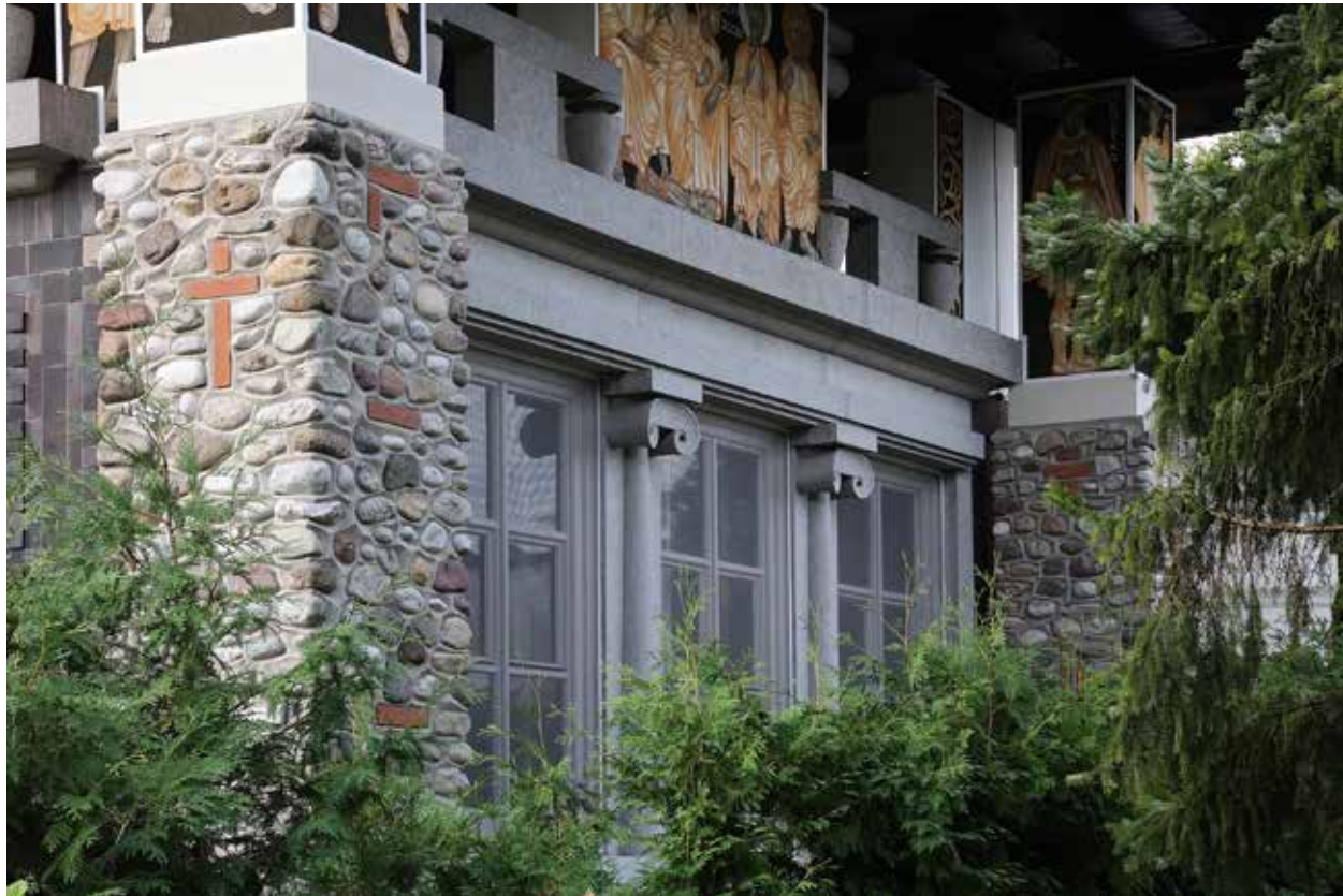
Obnovljena upravna stavba ŽALE, Plečnikove mizarske delavnice, 2015.
