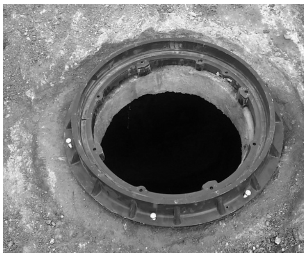
Slika 2, Vgradnja novega LTŽ okvirja pokrova na obstoječ AB venec (vir: https://www.kamnik.si/# )
